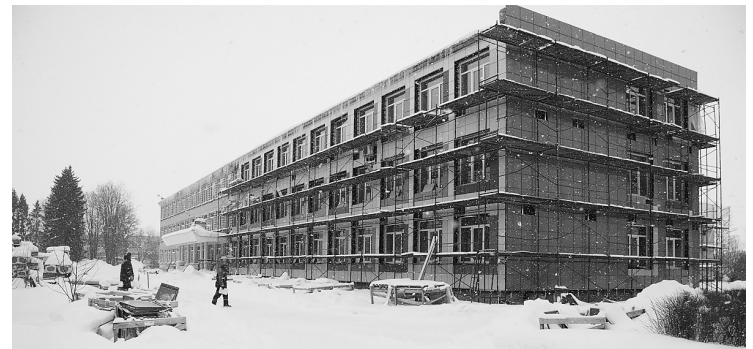
● Ремонт школы в Бегуницах
