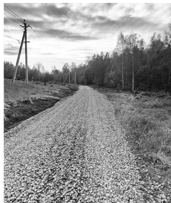
❖ Отсыпка дороги щебнем
