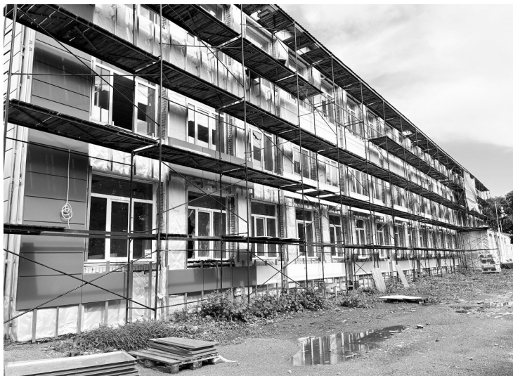
● Капитальный ремонт Яблонницкой школы
