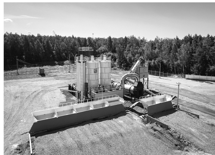
Новый завод выпускает 1200 тон асфальта в смену
